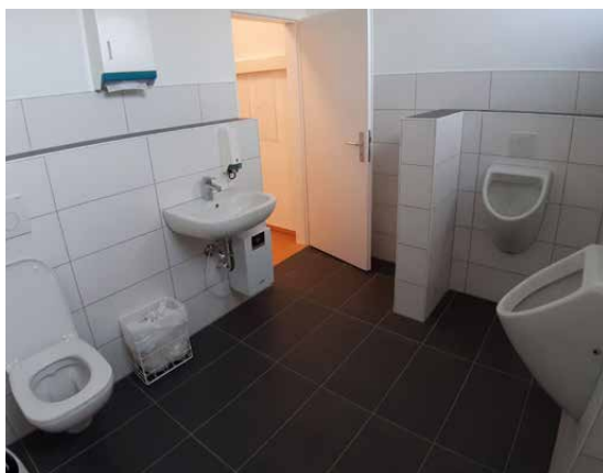
Sanierung Toilettenanlage Walkmühlenweg 5a
