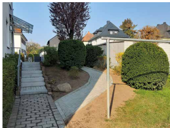
Neubau einer Rampe Austraße 27
