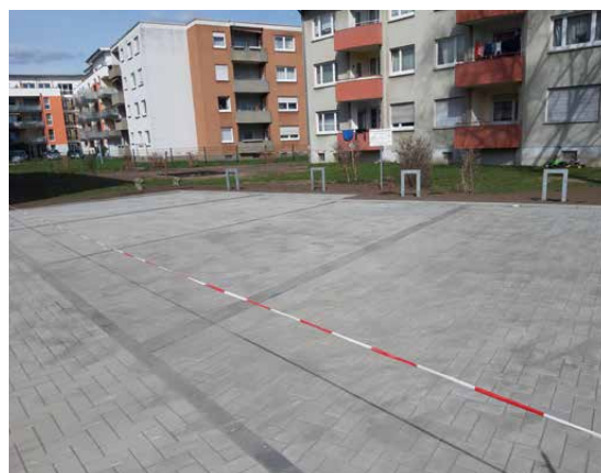
Neugestaltung der Außenanlage Alstedstraße 1
