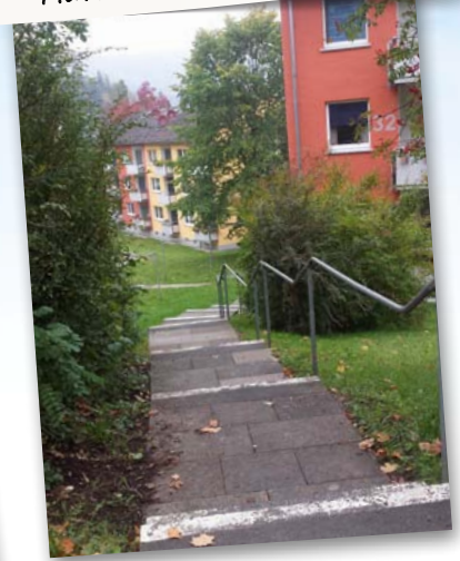
Mozartstraße 26 - 30 Platten angehoben
