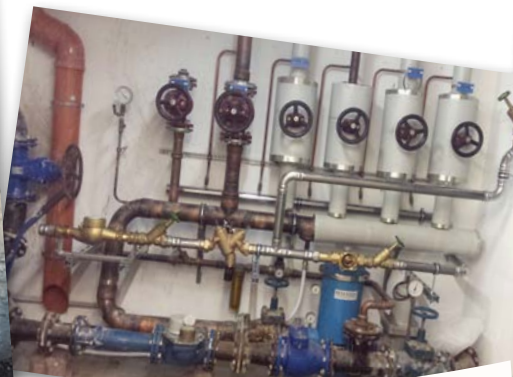
AWO-Liegenschaft Trennung des Löschwassers von der Trinkwasserleitung
