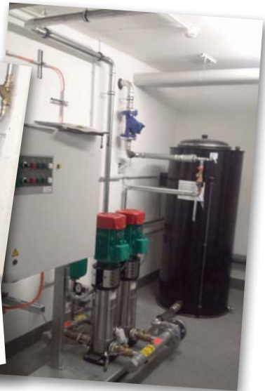
AWO-Liegenschaft Trennung des Löschwassers von der Trinkwasserleitung
