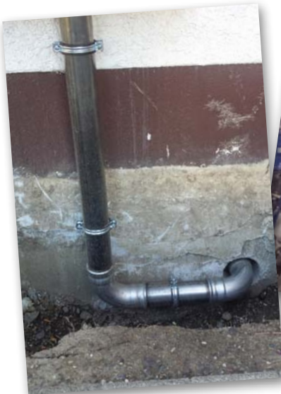
AWO-Liegenschaft Trennung des Löschwassers von der Trinkwasserleitung
