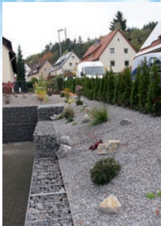
Der neu gesicherte Hang in der Eichendorffhöhe
