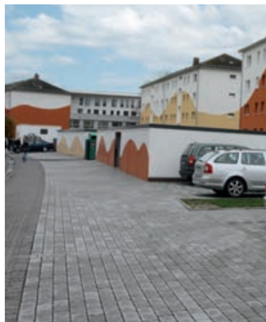
Frisch gepflasterte Garagenzufahrten im Walkmühlenweg
