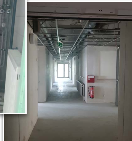
Erste Abbrucharbeiten im ehemaligen Pflegeheim im Walkmühlenweg 13
