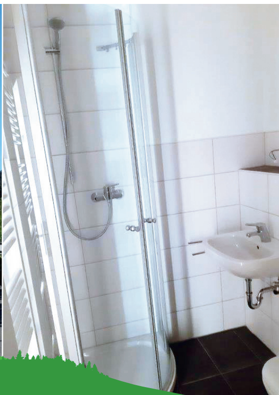
Blick in ein im Rahmen einer Einzelmodernisierung komplett saniertes Bad
