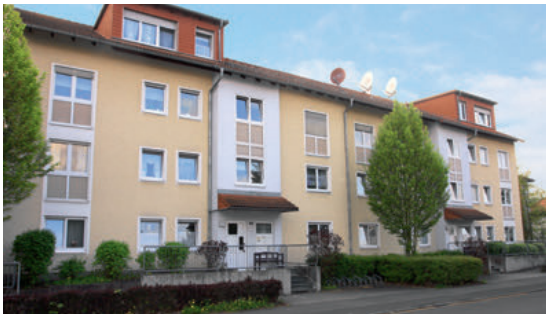
Konrad-Adenauer-Str. 58-60a: Außenanlage
