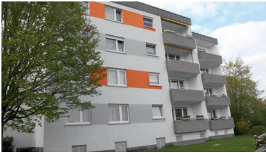
Händelstraße 4: Neuer Anstrich und Flachdachsaniegung
