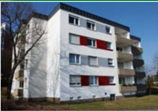
Händelstraße 2 nach Dach- und Fassadensanierung
