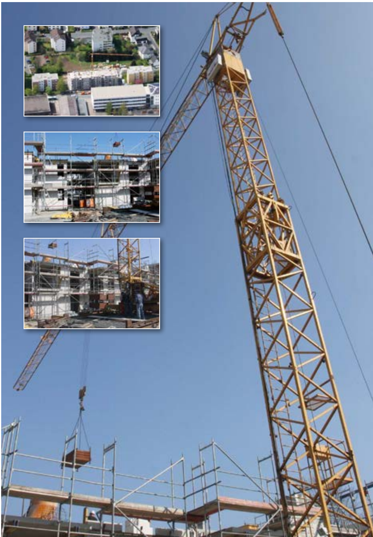
Ein Blick auf die Baustelle in der Konrad-Adenauer-Straße.
